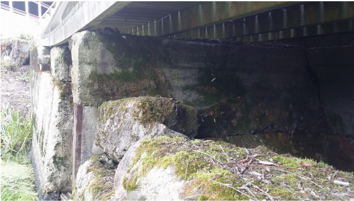
Kuva 9: Pato laiturin alta.
