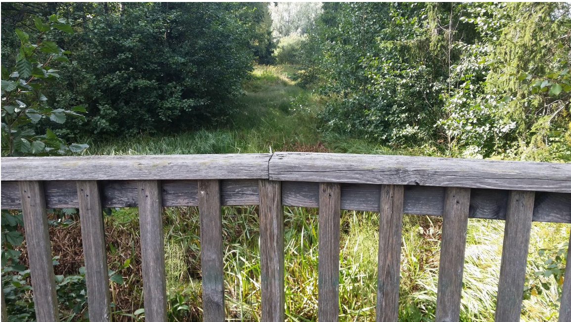
Kuva 12: Kuva Urheilukentälle johtavalta pikkusillalta joen yläjuoksun suuntaan, kesällä kasvillisuuden peittämä. Laskeutusallas, joka rajattu pienellä pohjaan rakennetulla kivipadolla.
