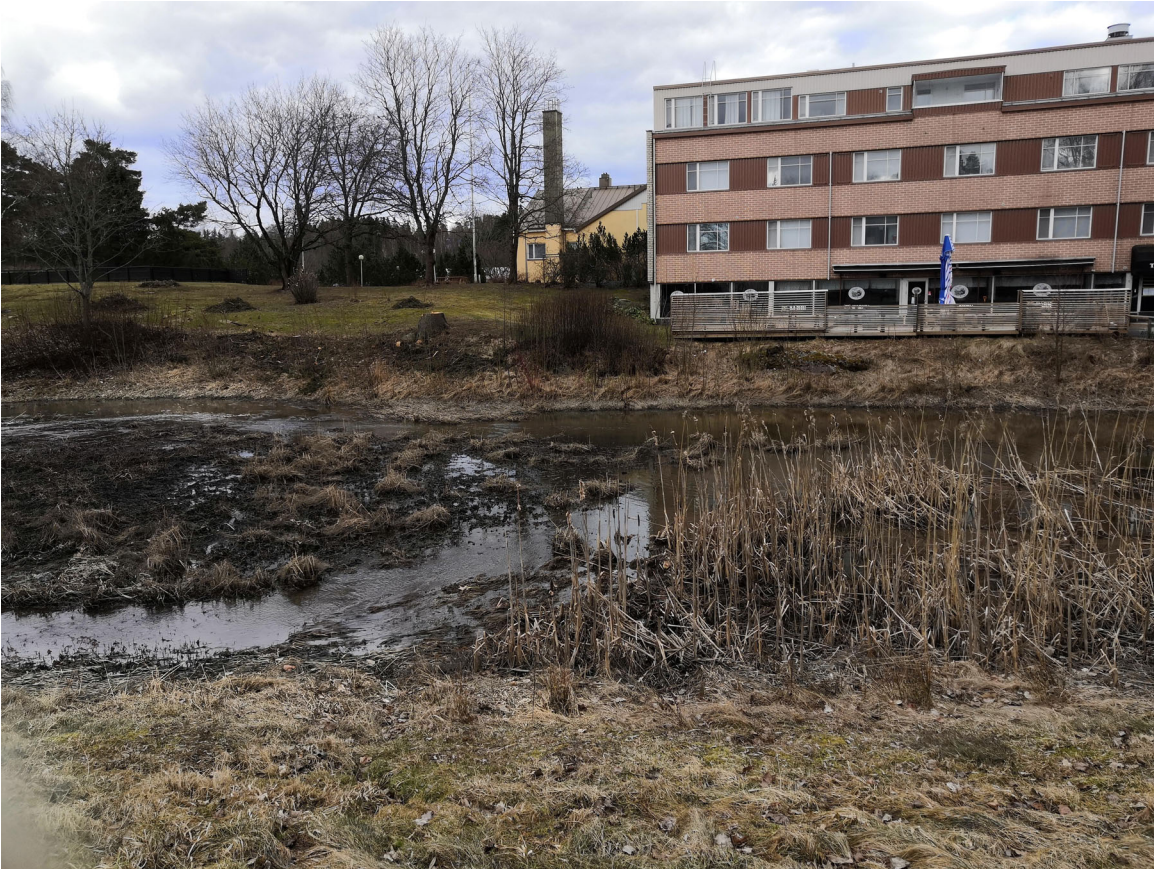
Kuva 7: Lampi Osuuspankin suuntaan (näky taustalla, keltainen rakennus)
