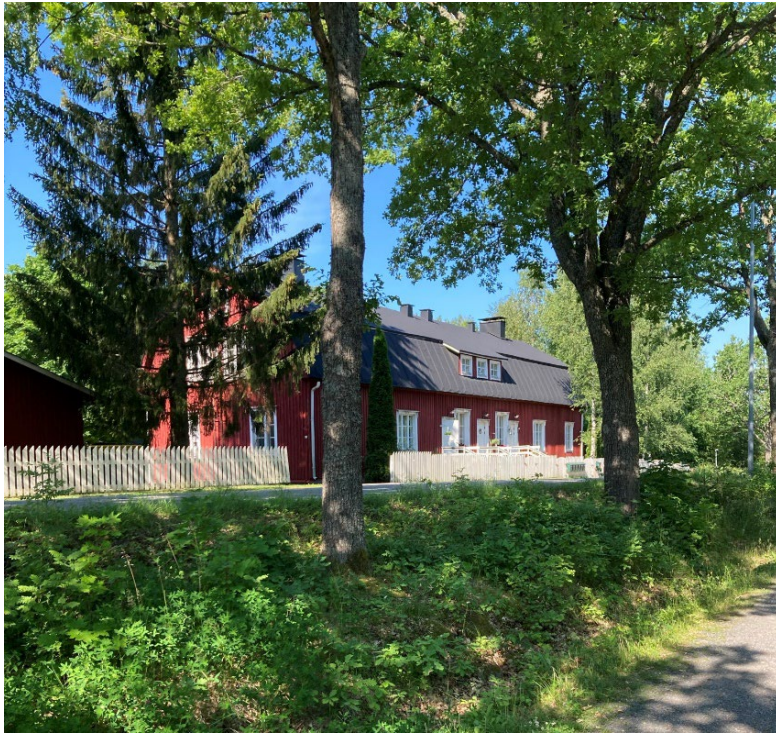
Kaava-aluetta vastapäätä oleva Tullintien suojeltu asuinrakennus. Rakennus ollut alkujaan riihi ilmeisesti v:lta 1859, muutettu v. 1918 työväenasuntolaksi.
