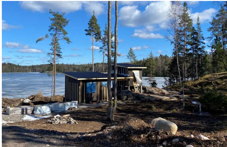
Rakenteilla oleva saunarakennus ja vierasmaja korttelin 7 rakennuspaikalla 1 kiinteistöllä 734-750-1-14 Mäntyrinta.
