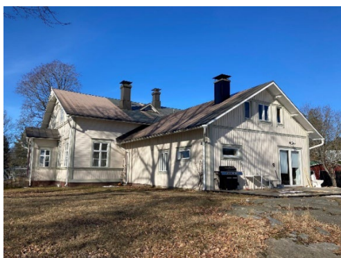
Valokuva rakennuksen itäpäädyistä.
