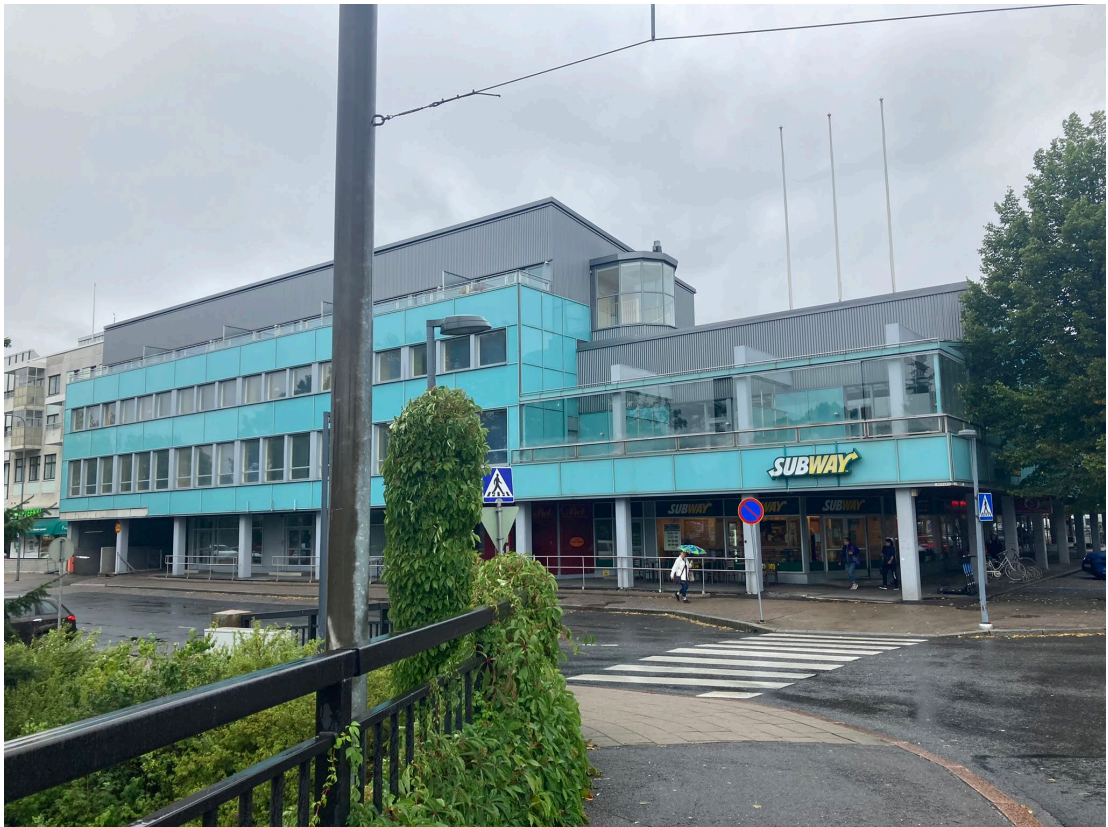
Kaavoitettavan rakennuksen Länsirannan puoleinen julkisivu.
