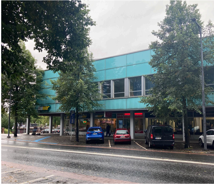
Kaavoitettavan rakennuksen Turuntien puoleinen julkisivu.
