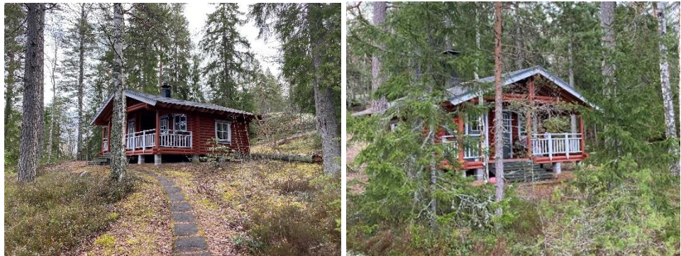
Saunarakennus kiinteistöllä 734-628-1-12 Rinne.
