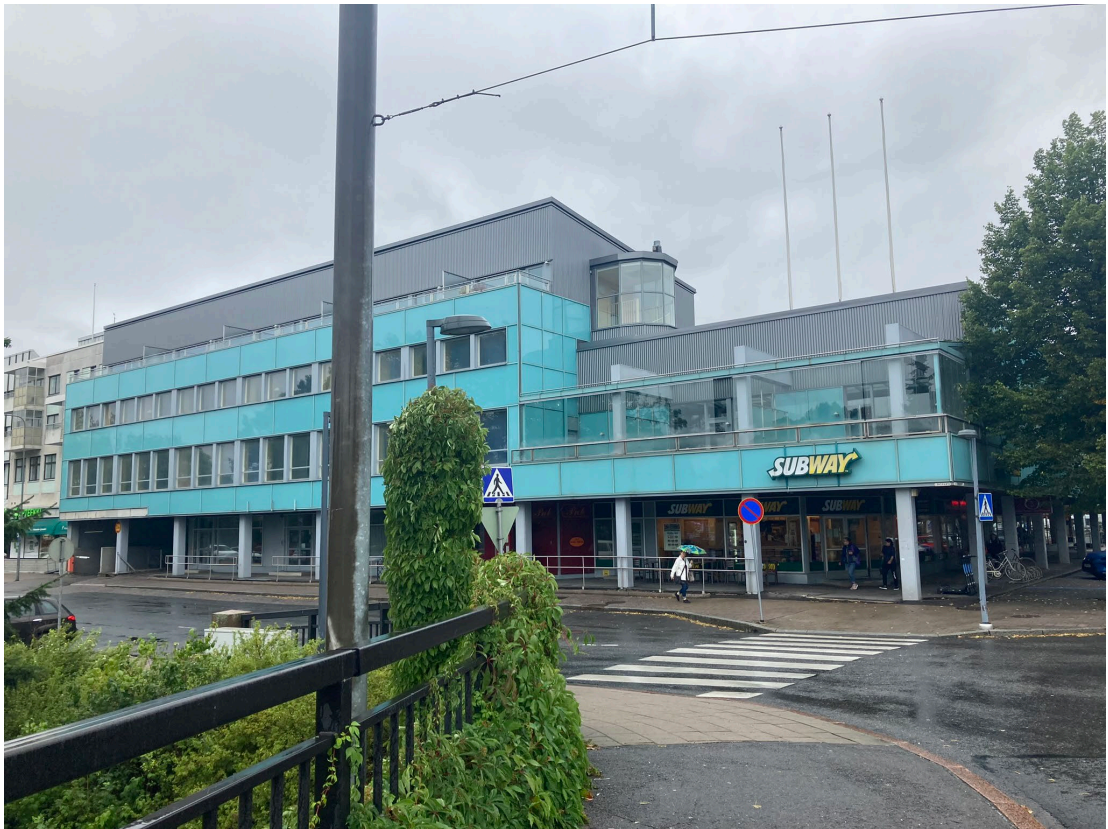
Kaavoitettavan rakennuksen Länsirannan puoleinen julkisivu.
