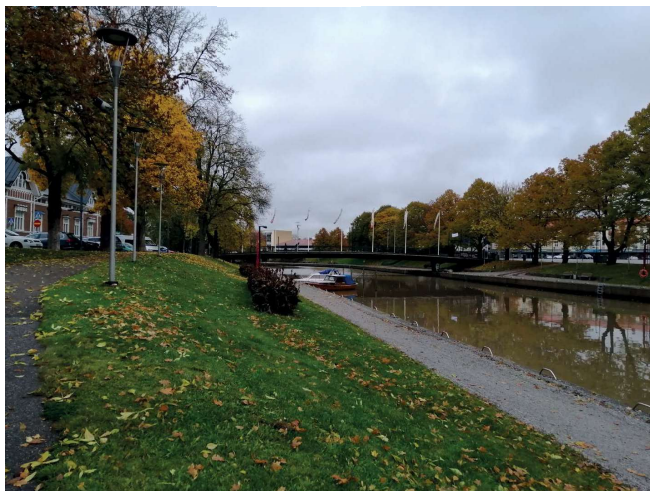
Betonitukimuuria Salon keskusta-alueella.
