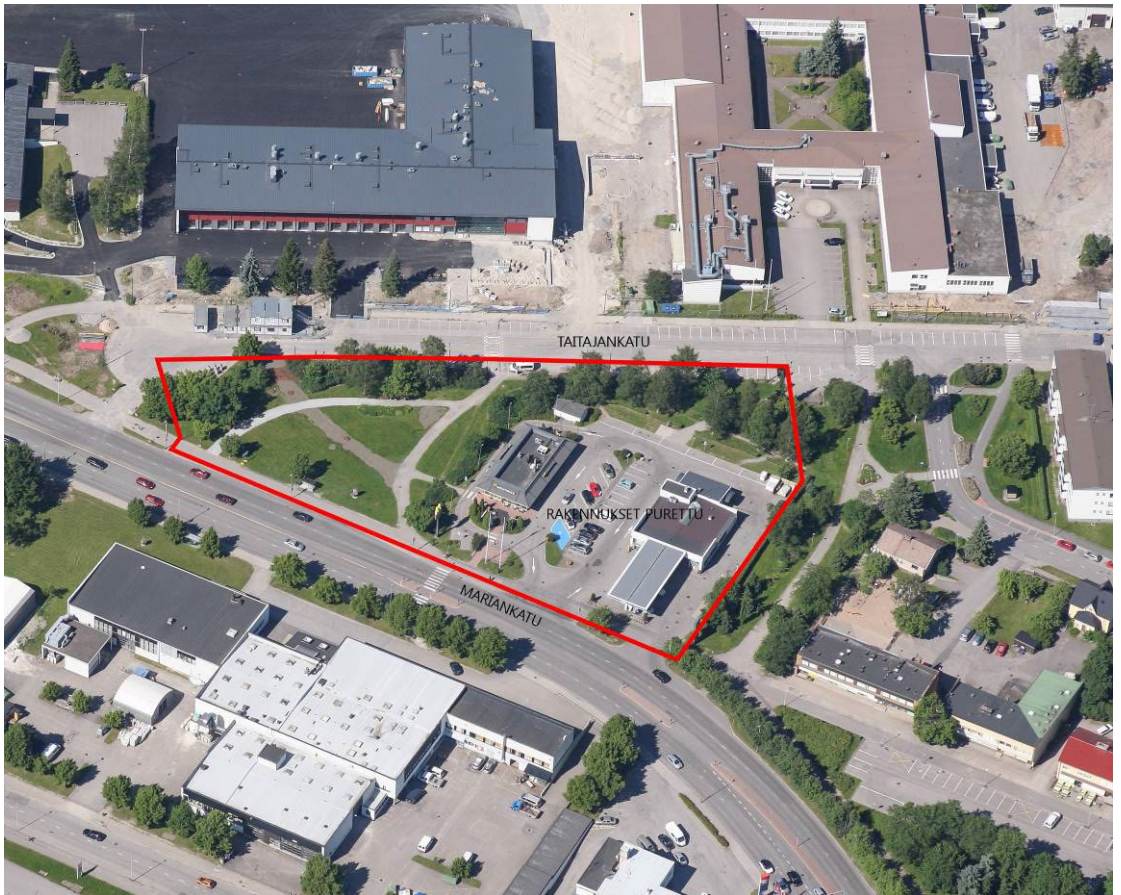
Kaavamuutosalue. VIISTOKUVA © 2015BLOM. kuvassa olevat rakennukset on purettu.
