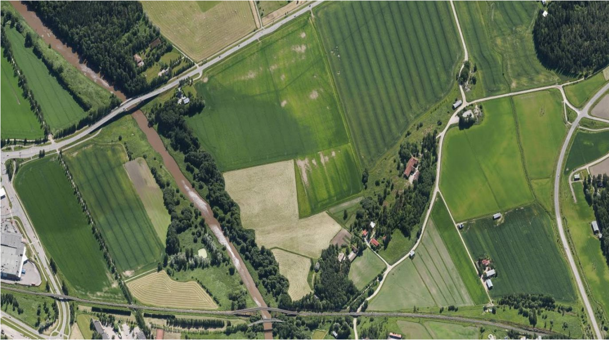
Näkymä etelään. Etualalla vanha ja uusi rautatiesilta, taustalla maantien 110 silta. Viistokuva © 2015 Blom.
