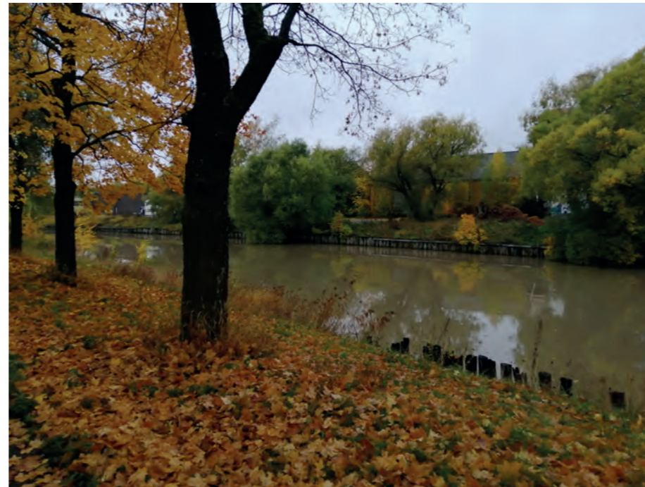
Puupaaluin tuettua joenpenkkaa rautatiesillalta etelään.
