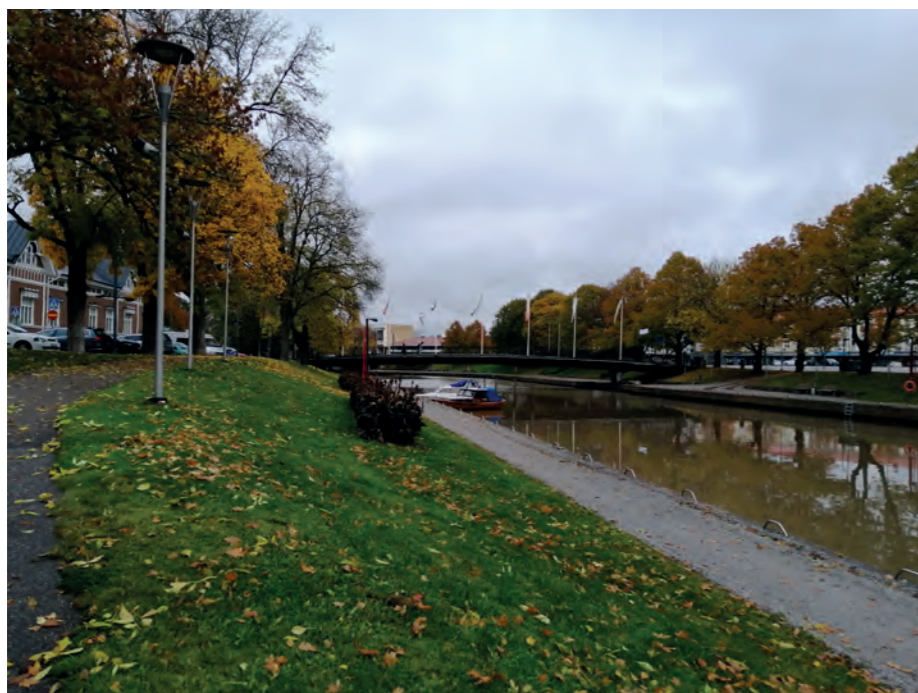
Betonitukimuria Salon keskusta-alueella.
