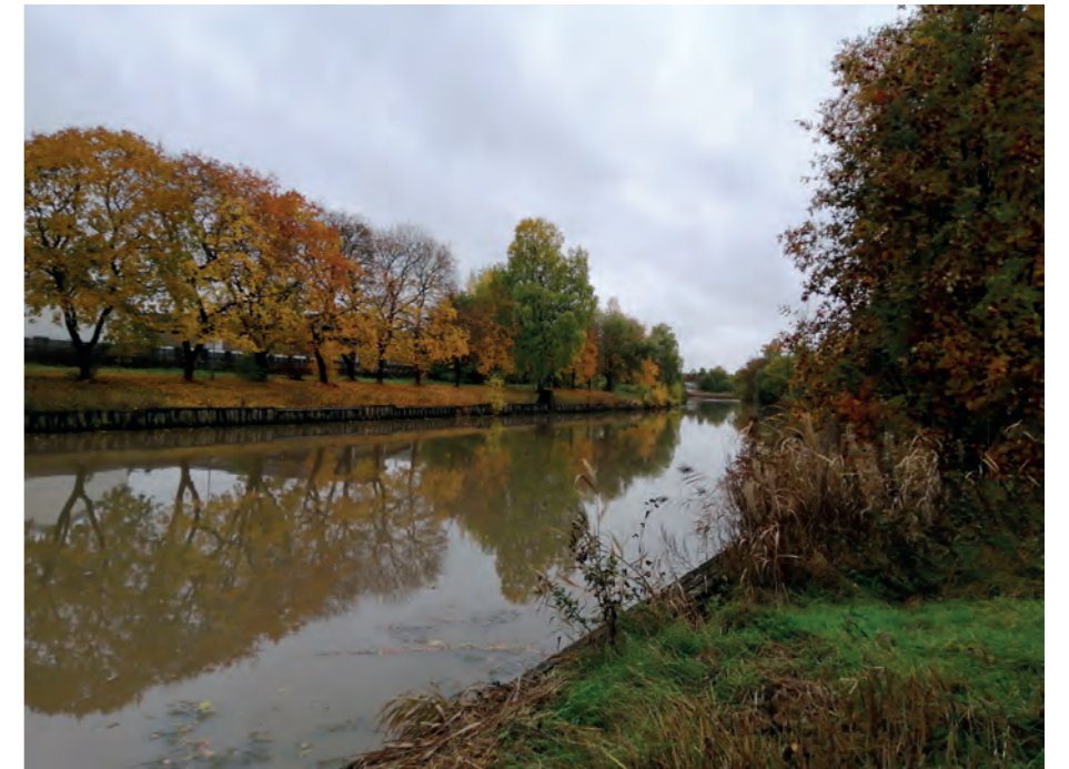
Kuva Salonjoen itärannalta heti rautatiesillan jälkeen. Alueen vehreys on yksi sen arvoista. Kuvassa näkyy myös puupaalutuentaa, joka on tarkoitus korvata uudella tukimuurilla.
