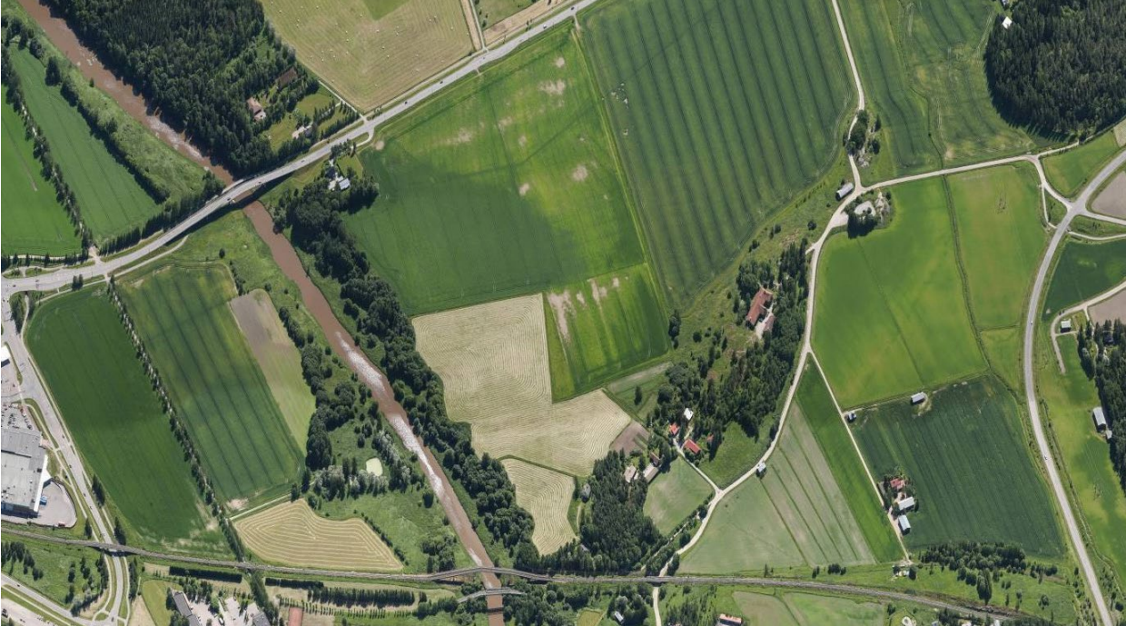
Näkymä etelään. Etualalla vanha ja uusi rautatiesilta, taustalla maantien 110 silta. Viistokuva © 2015 Blom.
