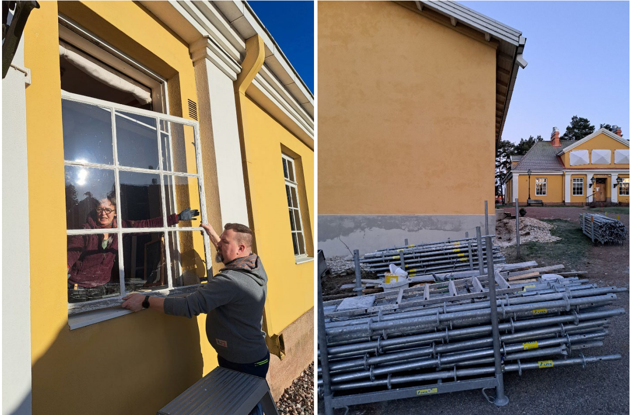
Perniön museon v. 1930 valmistuneen päärakennuksen ikkunat korjattiin ja aitan pääty sai uuden rappauksen. Kuvat: Mia Juva ja Anna Väänänen.
