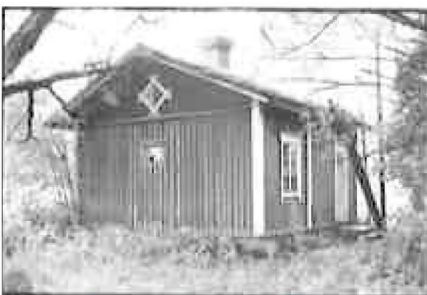
Kuva rakennuksesta vuodelta 1986. Kuva otettu pohjois- länsi kulmasta. Silloin rakennus oli vielä hyvässä kunnossa. @Turun museokeskus, Ulla Lähdesmäki
