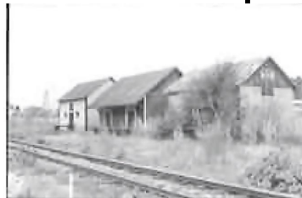
Aseman makasiinit jouduttiin purkamaan vuonna 1989 , kun rantarataa siirrettiin hieman.
