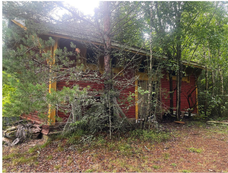
Kuva otettu 2.7.2023. Kuva radan puolelta koillisesta.
