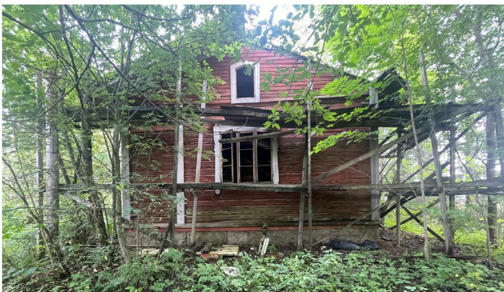
Kuva 2.7.2023. Kuva rakennuksen lansipäädystä. @Salon kaavoitus. Kuvaaja Eeva Huittinen
