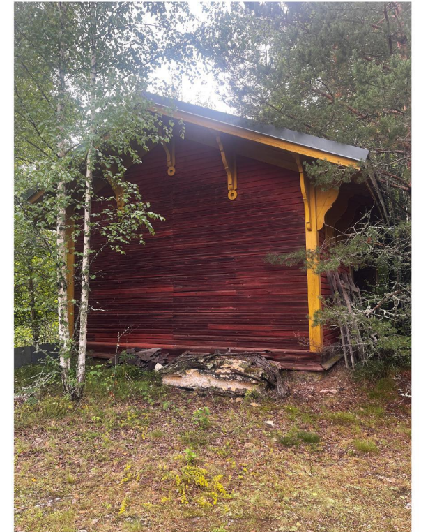
Kuva otettu 2.7.2023. Rakennuksen kaakkoispäätty
