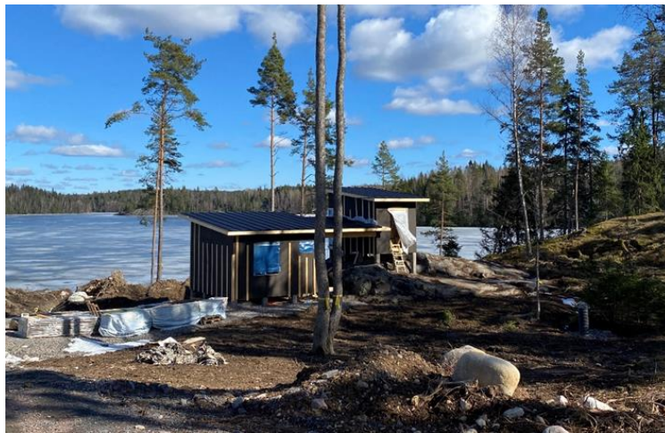
Rakenteilla oleva saunarakennus ja vierasmaja korttelin 7 rakennuspaikalla 1 kiin-teistöllä 734-750-1-14 Mänty-ranta.
