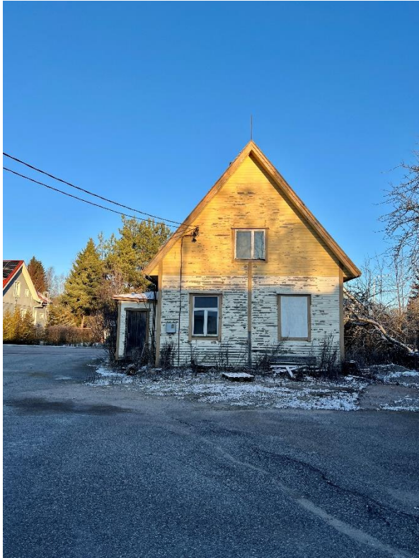
Talo 8, näkymä pihan puolelta
