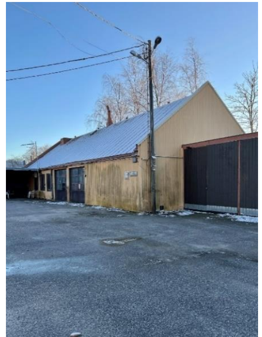
Vanhimman, korkeimman talousrakennuksen tiiliseinä on vuorattu aaltopellillä.
