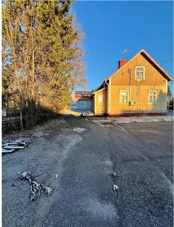
Talo 10, näkymä pihan puolelta.
