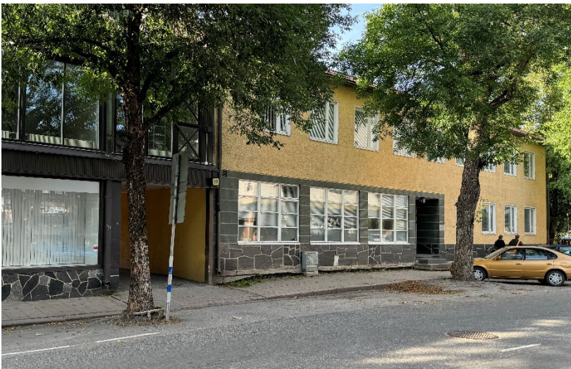
Vanha päiväkotiki Asemakadun suunnasta kuvattuna. Kadun puoleinen liuskekivi julkisivu näkyy kuvassa.
