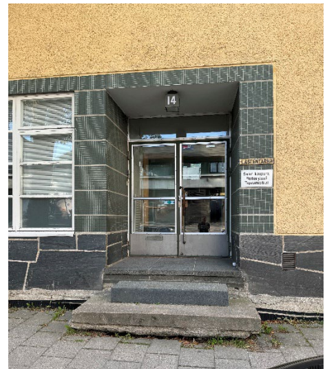
Nykyään ainut sisäänkäynti kadun puolelta.
