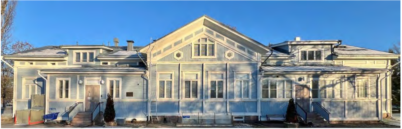
Julkisivu pihan puolelta katsottuna. Pihan puolella on kaksi pulpettikattoista sisäänkäyntiä, joiden alapuolella kuistit.
