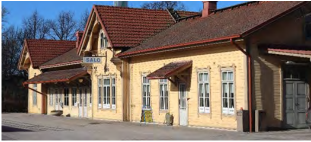
Valokuvia kaava-alueen lähiympäristössä olevista puisista rakennuksista ja RKY alueen rakennuksista.
