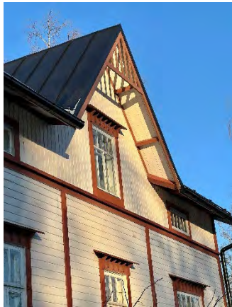
Katua kohti olevassa julkisivussa frontoni, jossa on vaatimaton tympanonkoriste.
