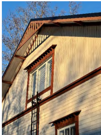
Vähäsillan kadun puoleinen yläikkuna poikkeaa muista ikkunoista.
