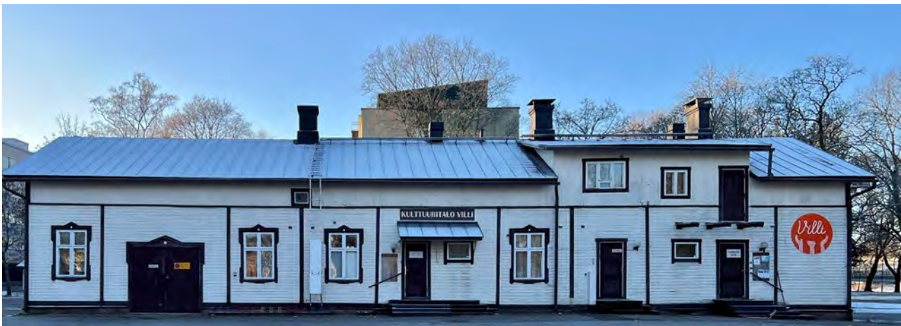
Julkisivu sisäpihan puolelta.
