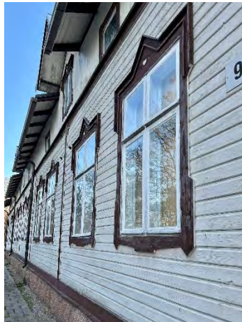
Ikkunat ovat symmetrisesti aseteltu ja rytmittävät julkisivua.
