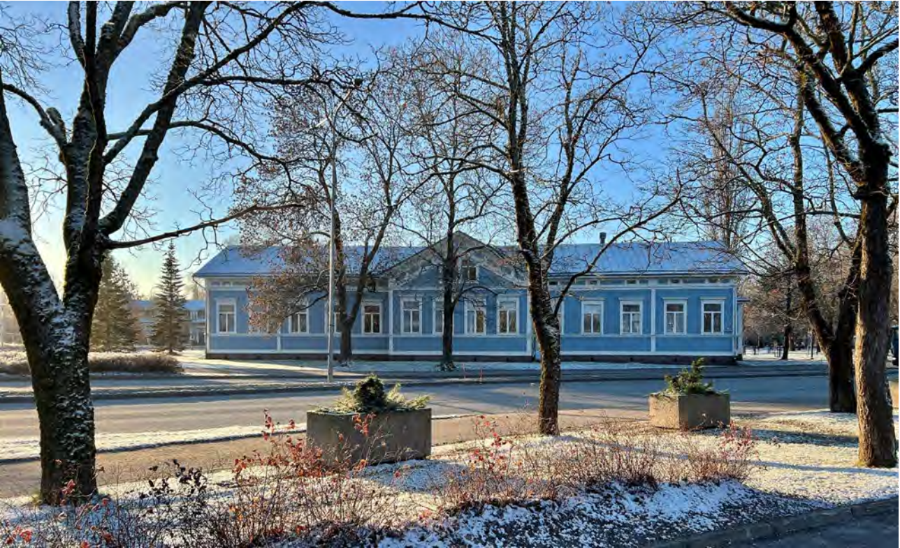
Julkisivu vanhasta kaupungintalosta torilta päin.
