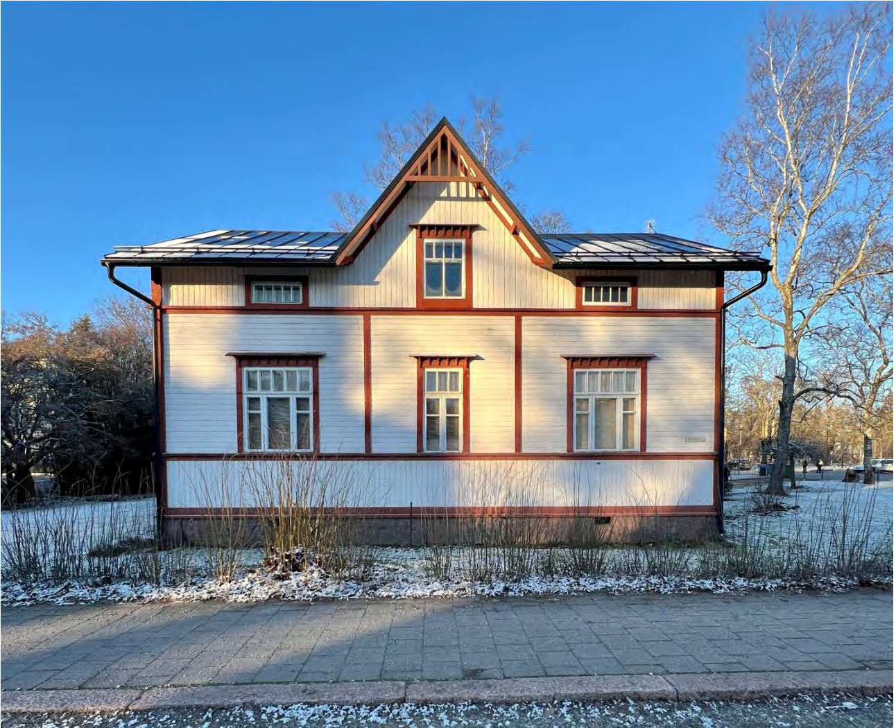
Julkisivu Tehdaskadulta katsottuna.
