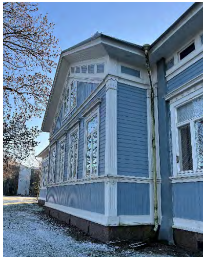
Julkisivuissa on risaliitteja jotka tuovat rakennukseen jäseneltyä symmetriaa.
