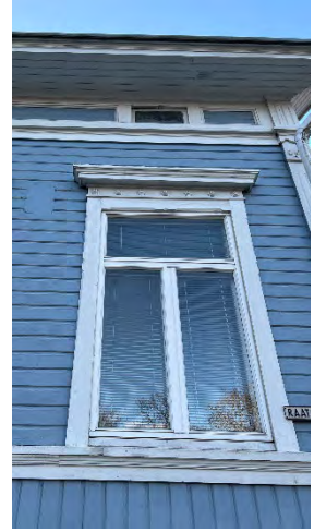
Pihan puolella näkyvät smyygilistat, jotka ovat tyypillisiä rakennusajan yksityiskohtia.
