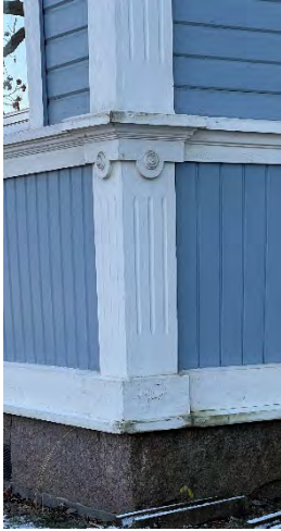
Kulmien pilastereissa klassista ornamentiikkaa, lisäksi vaakalistat hallitsevia. Kuistien alla kasetointia.
