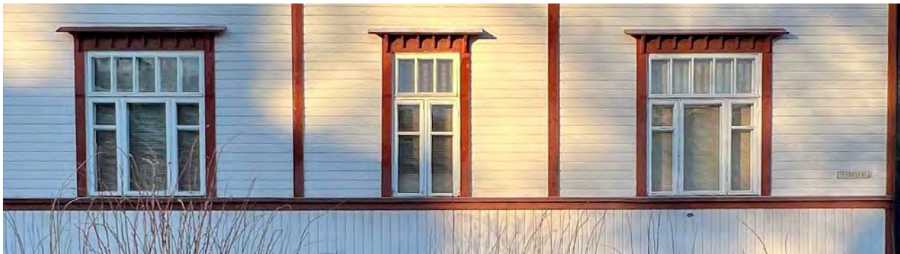
Ikkunat enimmäkseen T-mallisia, yläosat jaettu kolmeen ruutuun. Pääjulkisivussa kaksi suurempaa moniruutuista ikkunaa. Ikkunoiden ylälaudoissa pieniä konsoleita, jotka tuovat rakennukseen perinteisen ilmeen.
