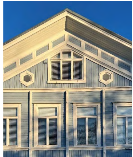
Frontoni eli päätykolmio sisäpihan puolelta katsottuna. Kuvassa näkyvät myös Ikkunat, jotka ovat pääosin T-mallisia. 2. kerroksessa pihan päätykolmiossa myös pienet ruusuikkunat.
