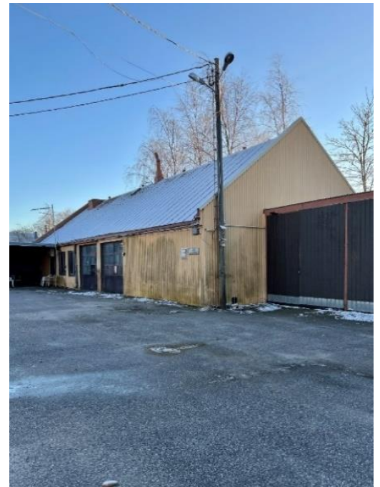
2 Vanhimman, korkeimman talousrakennuksen, verstaan tiiliseinät ovat nykyisin vuorattu pääosin aaltopellillä.
