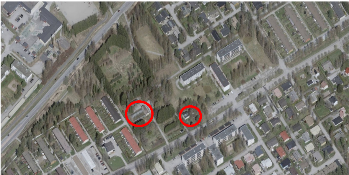
Kuva 2. Suunnittelualueen rakennettu osa viistoilmakuvasa toukokuu 2023. Puretut rakennukset on merkitty punaisella ympyrällä. © Salon kaupunki
