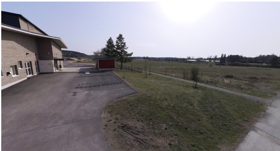
Uuden alakoulun länsisivu. Nykyinen tontti loppuu kulkureitin varteen.
