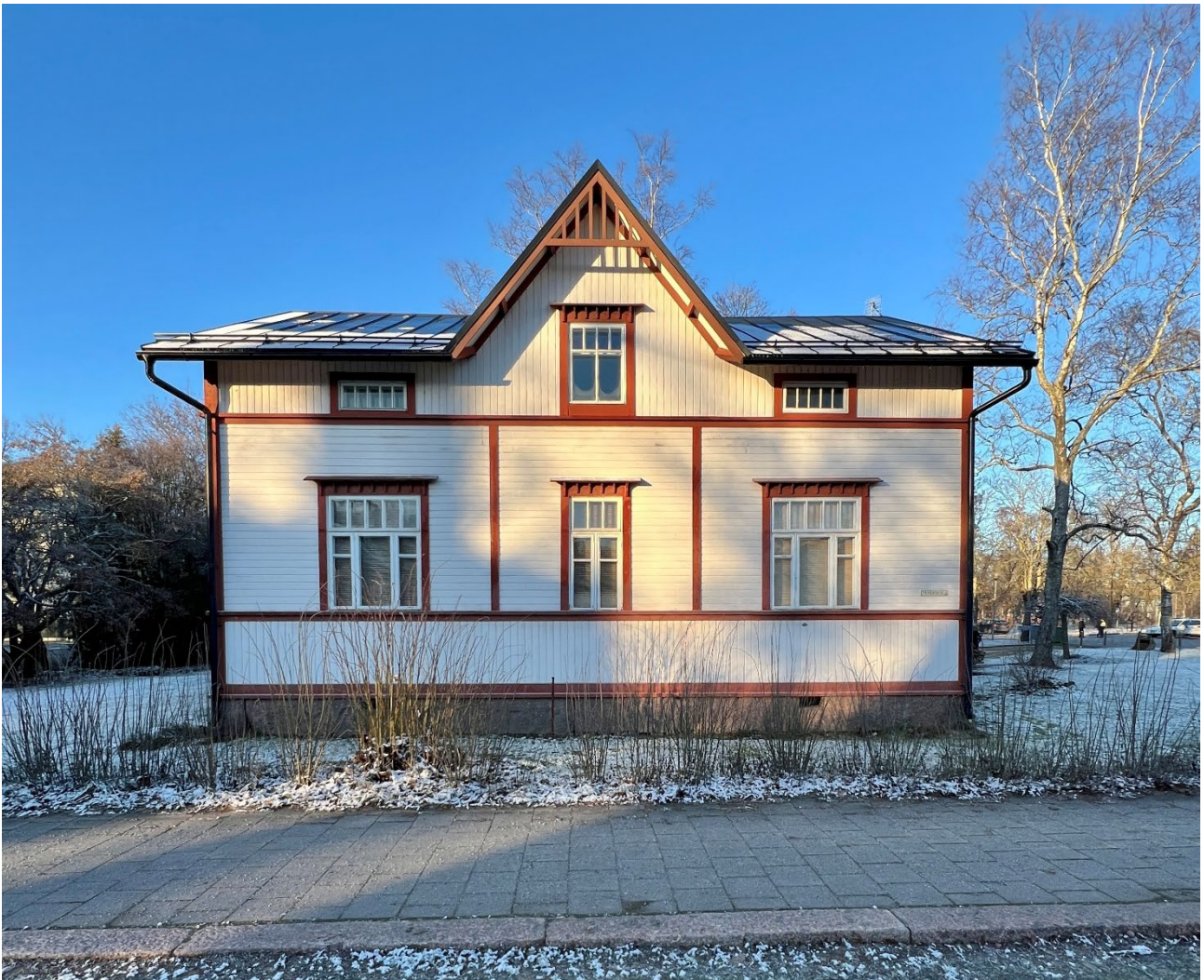
Julkisivu Tehdaskadulta katsottuna.
