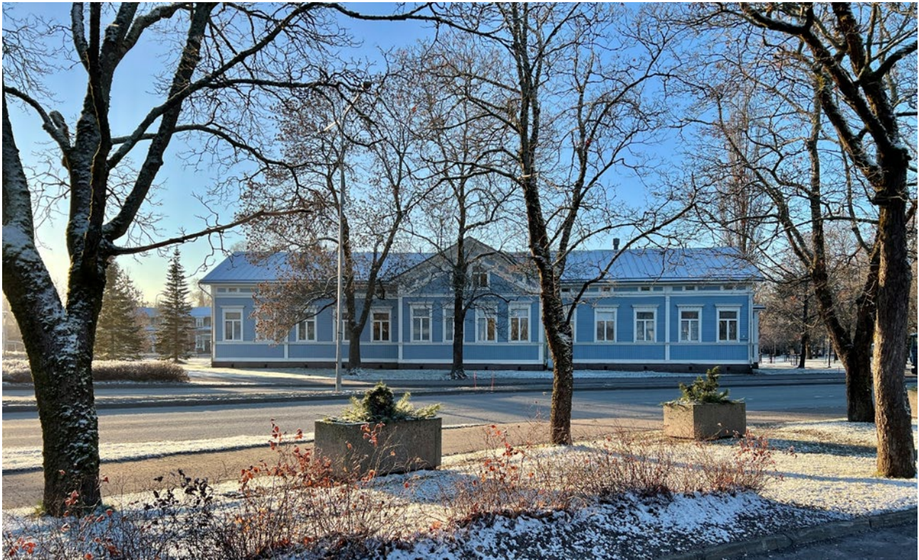
Julkisivu vanhasta kaupungintalosta torilta päin.
