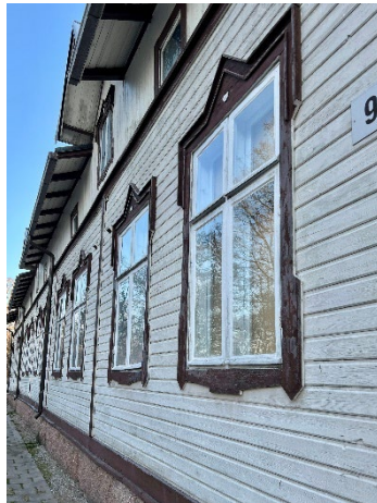
Ikkunat ovat symmetrisesti aseteltu ja rytmittävät julkisivua.
