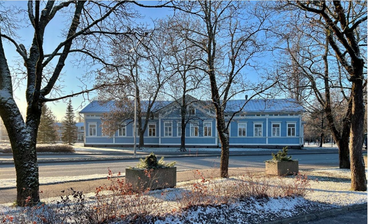
Julkisivu vanhasta kaupungintalosta torilta päin.
