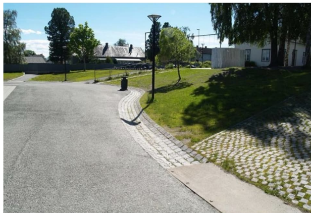
Kuva 3.2. Periaatekuva huleveden paikallisesta hyödyntämISRakenteesta. (Lähde, Tampere ohjekortti, hyödyntämISRakenne. Oikealla esimerkki huleveden johtamisesta kivetysssä sivupainanteessa (kuva RudusPiha).
