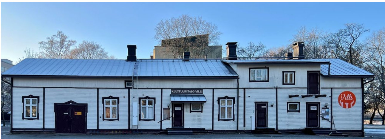
Julkisivu sisäpihan puolelta.
