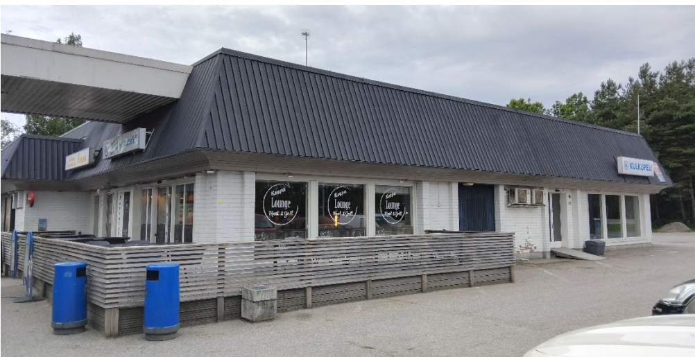
Huoltoasemarakennuksen koillisjulkisivu. Kuva otettu 5.8.2026.
