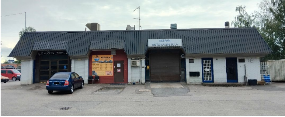
Huoltoasemarakennuksen luoteisjulkisivu. Kuva otettu 5.8.2026.
