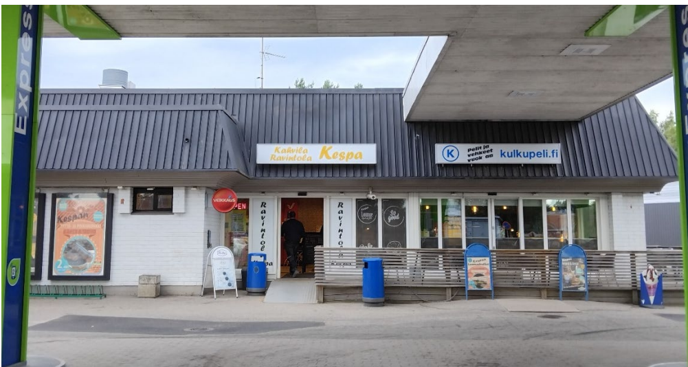
Kuvissa huoltoasemarakennuksen kaakkoisjulkisivu. Kuvat otettu 5.8.2026.
