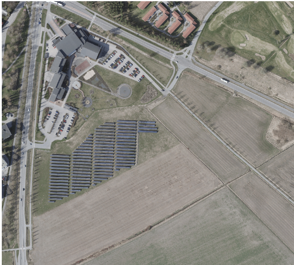
Ilmakuva (2023) sijoitusalueesta. Ylempänä Salon lukio ja keskellä säilyvä aurinkovoimala.
