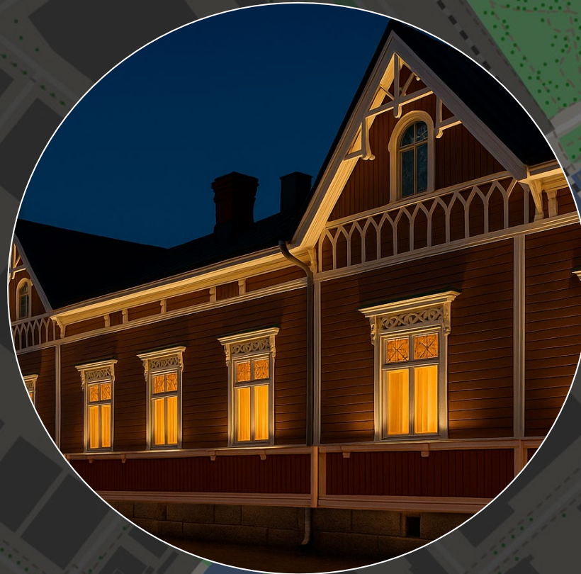
Esimerkki vanhan kauppalamiljöön puutalon pehmeästä julkisivuvalaistuksesta, joka nostaa rakennuksen yksityiskohtia esiin ilman, että rakennus tulee esiin liikaa katunäköymässä.
