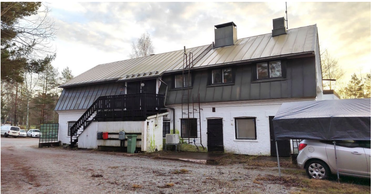
Vanhan navettarakennuksen pohjois- ja eteläjulkisivut. Kuvat: Elisa Nuora
