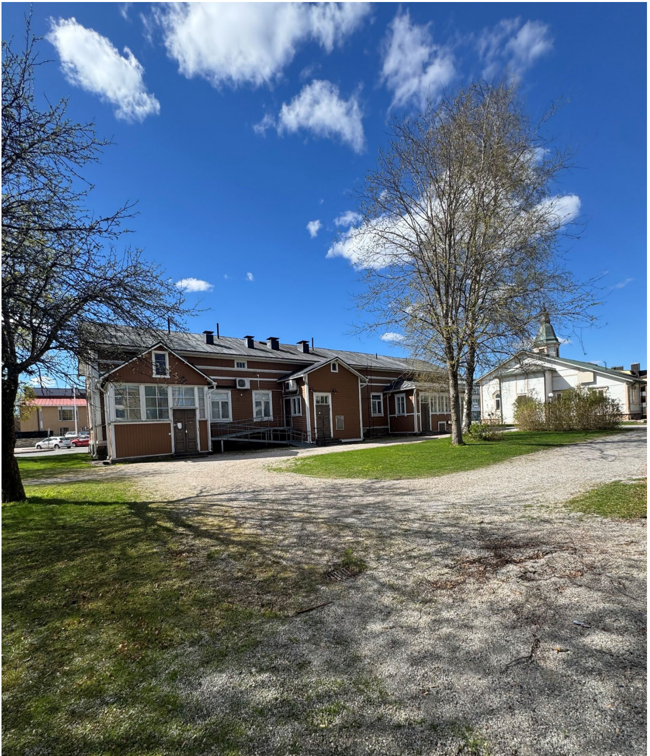
Kuva 8 Valokuva otettu uuden kerrostalon rakennuspaikan kohdalta. Kuvassa näkyy hyvin molemmat olemassa olevat rakennukset.
